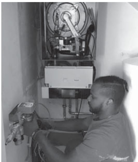
Foto Fa. Reichert: Alezar Brehan bei Installationsarbeiten
